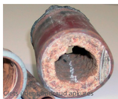
Cietis ūdens samazina apkures katlus - tas arī ievērojami samazina apkures sistēmas siltuma efektivitāti
